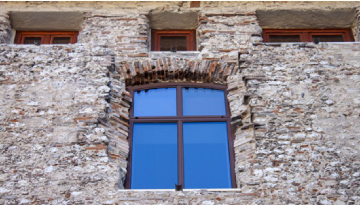
Palazzo Cresi, L'Aquila
